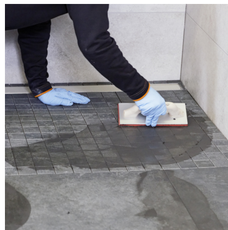
Jointoiement très facile sans voile résiduel avec PCI Durapox Premium (Multicolor).
