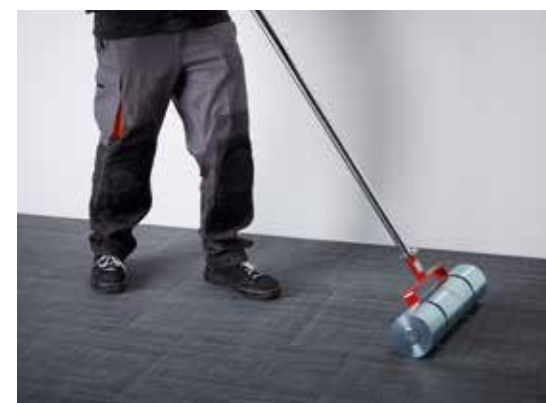
Maroufflez les formes sur la totalité de la surface à l'aide du rouleau marouffleur.
