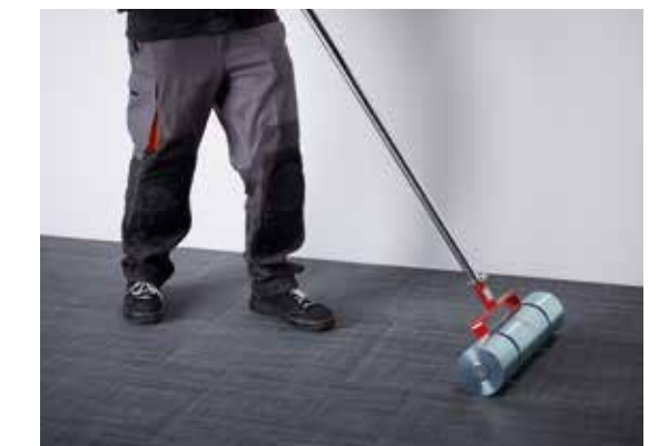
Maroufflez les triangles sur la totalité de la surface à l'aide du rouleau marouffleur.
