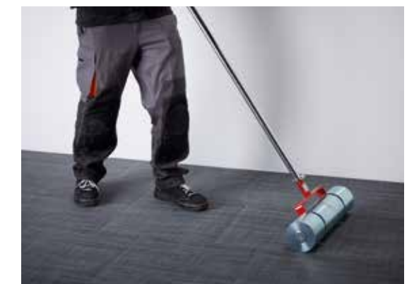
Maroufflez les gammas sur la totalité de la surface à l'aide du rouleau marouffleur.
