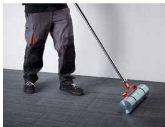
Marouflez les dalles sur la totalité de la surface à l'aide du rouleau maroufleur.
