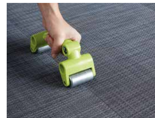
Marouflez les joints à l'aide du rouleau presseur.
