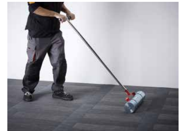
Marouflez les lames sur la totalité de la surface à l'aide du rouleau maroufleur.
