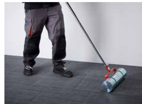
Maroufflez les prismes sur la totalité de la surface à l'aide du rouleau marouffleur.
