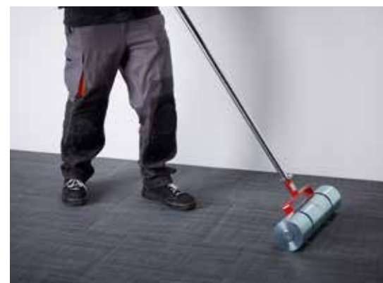
Maroufflez les demi-hexagones sur la totalité de la surface à l'aide du rouleau marouffleur.
