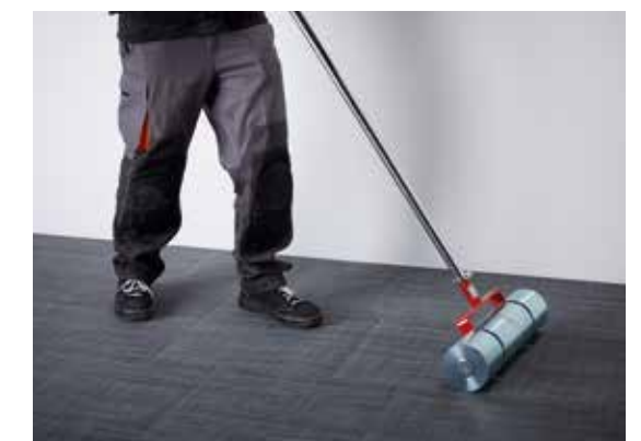
Maroufflez les formes sur la totalité de la surface à l'aide du rouleau marouffleur.
