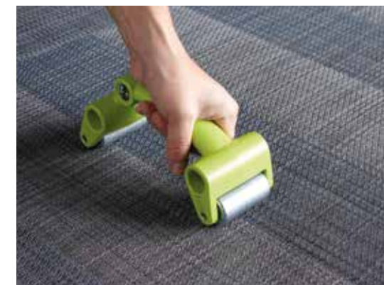
Maroufflez les joints à l'aide du rouleau presseur.
