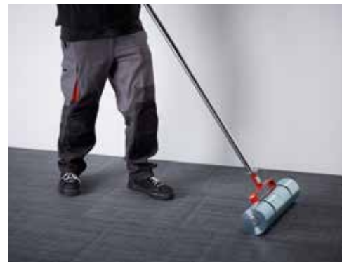
Marouflez les lames sur la totalité de la surface à l'aide du rouleau maroufleur.
