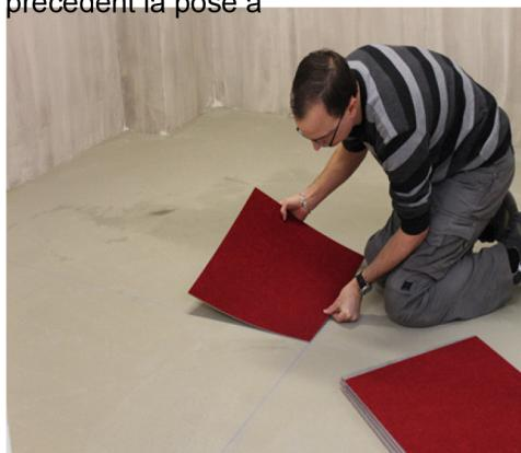
**4** Mettre en place la 1ère dalle en suivant les axes de pose. Poser et maroufler, joints bien serrés, les dalles entières suivantes, sur l'ensemble de la surface. En fonction des dessins, la pose peut être contrariée à n'importe.
